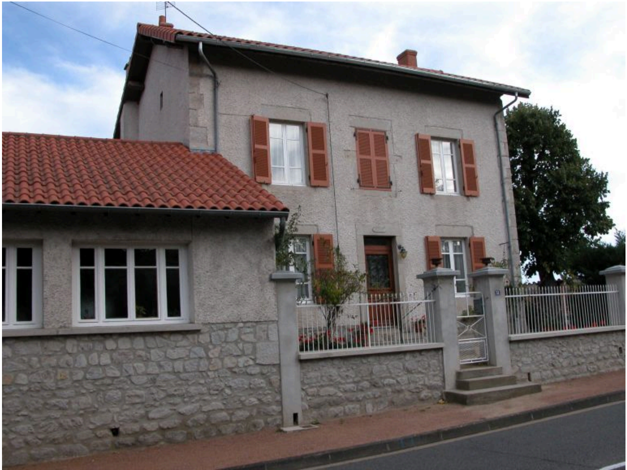
Saintinieux, Maison 1986 AR 5. Vue d'ensemble du logis sur la rue.
