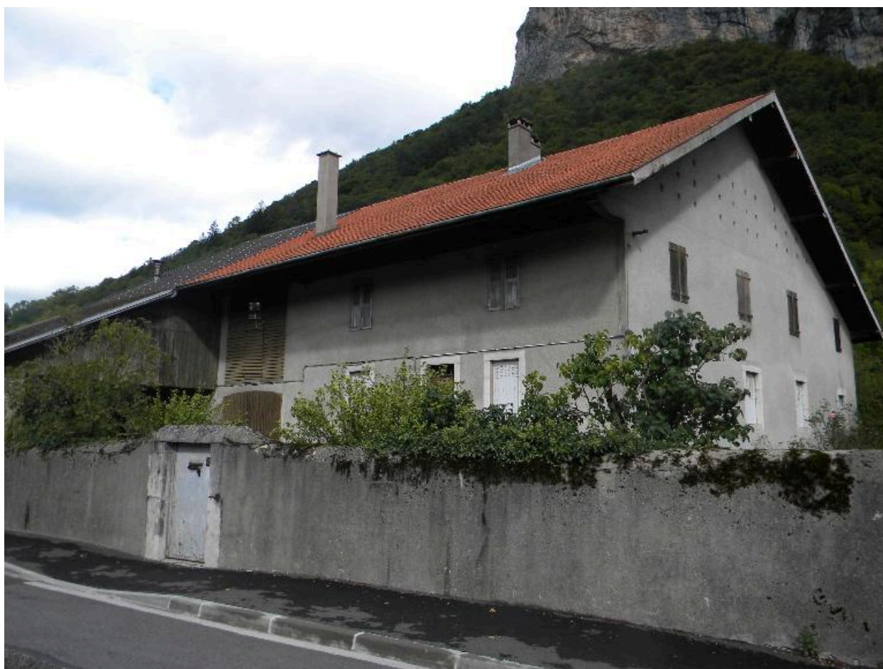
Façade principale d'une ancienne ferme (2008 C6 892)
