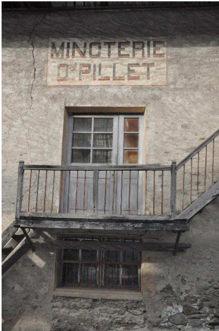
Détail de l'enseigne peinte sur la façade du moulin.
