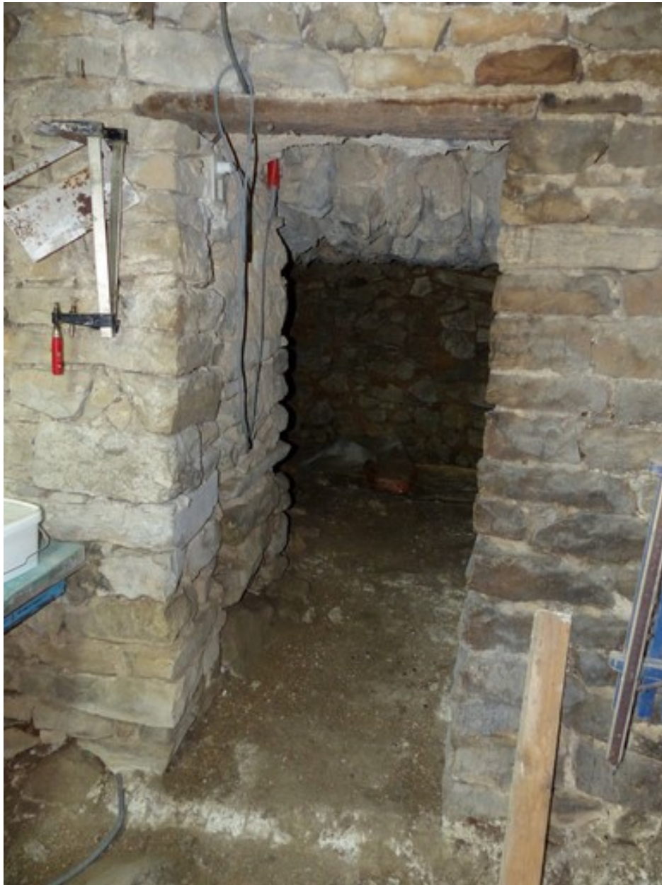
Etage de soubassement, mur nord. Porte de l'étable à cochon.
