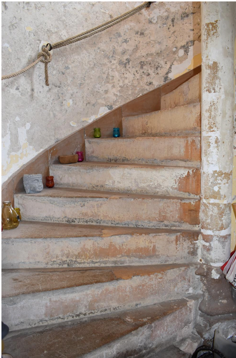
Escalier en vis vue générale.
