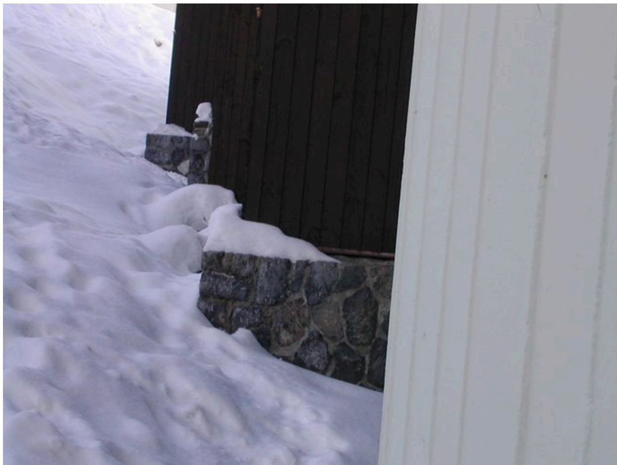
Détail des matériaux : soubassement pierre, essentage et enduit
