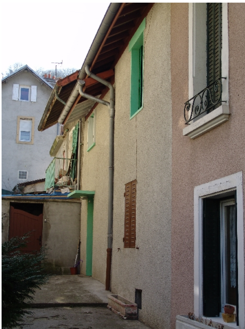
Détail de l'élévation nord
