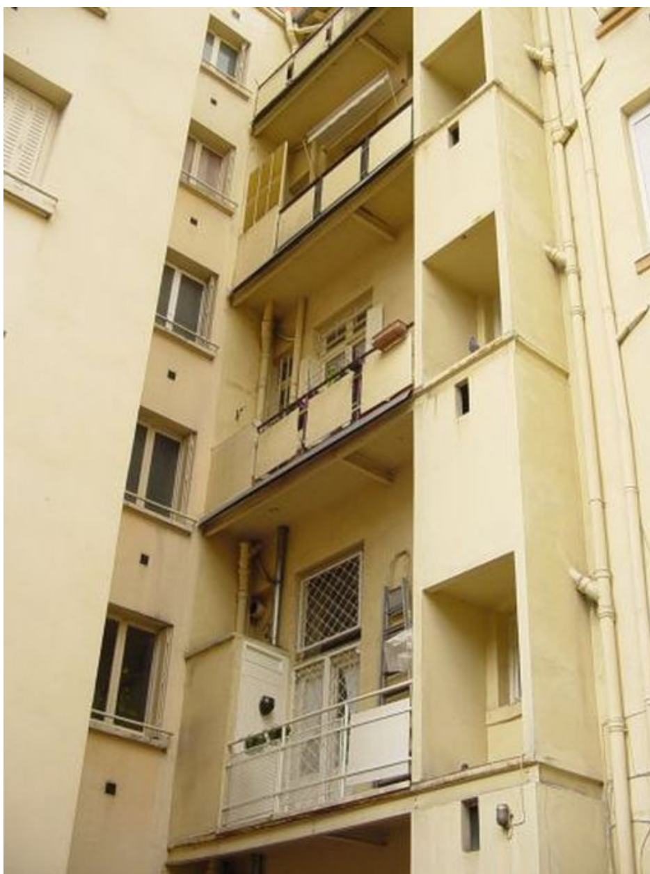
Façade postérieure sur cour
