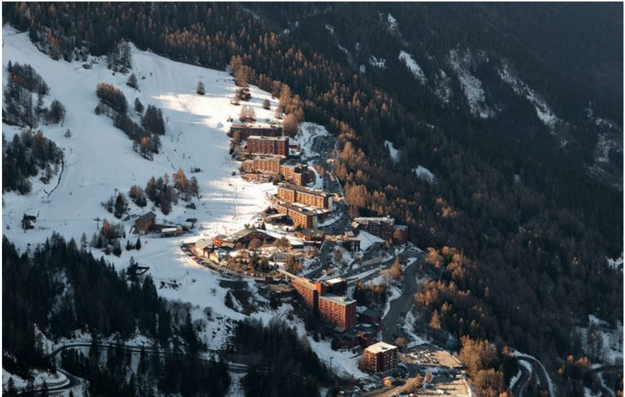
Vue aérienne. Vue rapprochée depuis l'est
