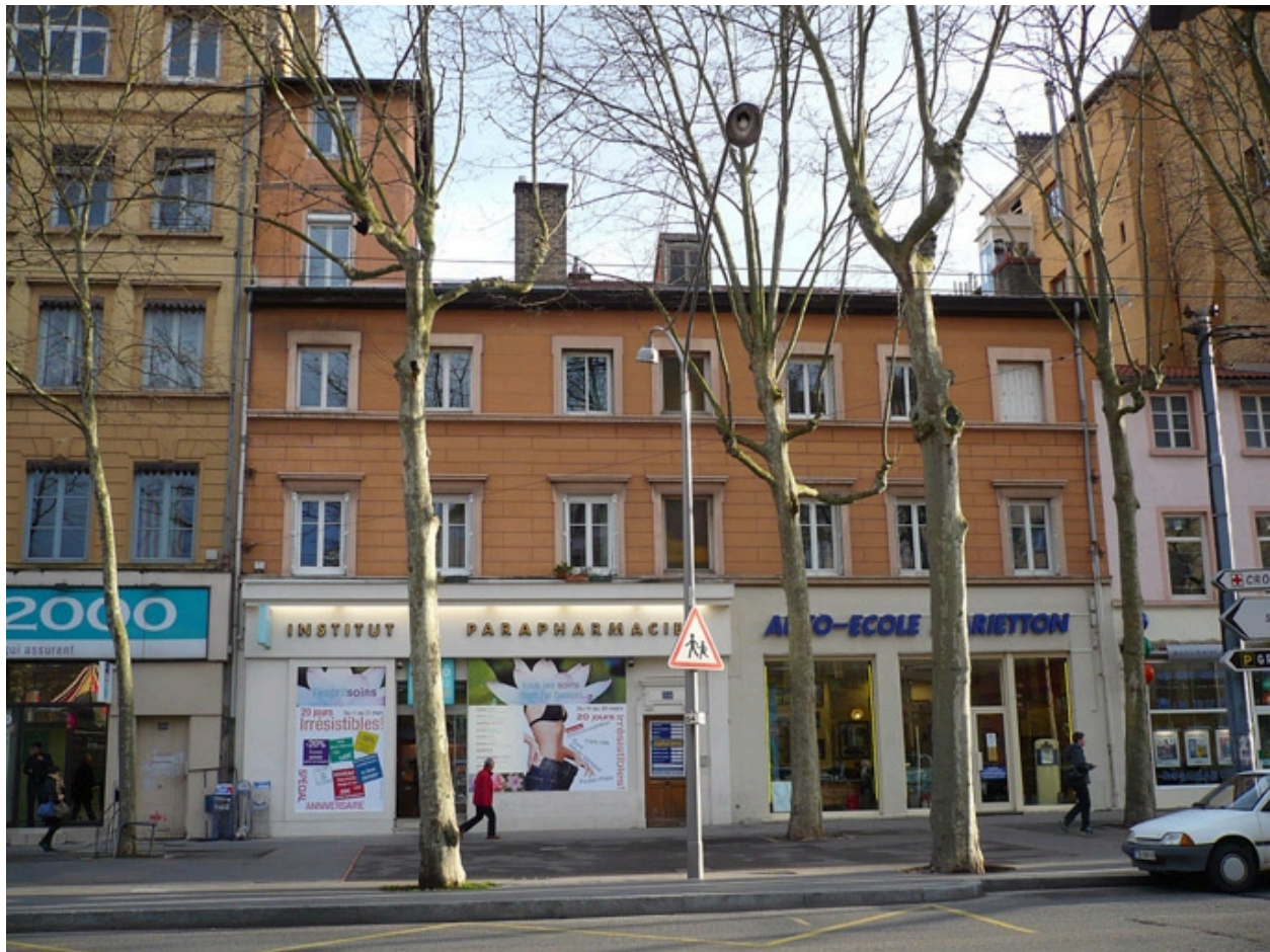
Vue générale nord, façade principale
