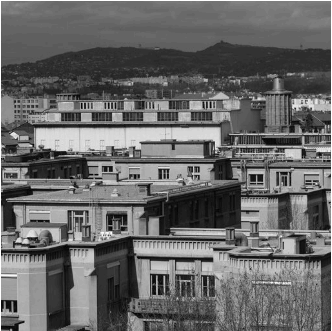
Vue d'ensemble du toit depuis le sud-est
