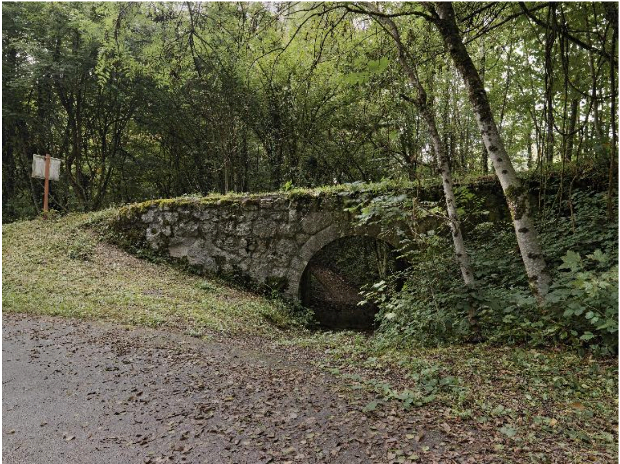
Varnaz (commune de Pugny-Chatenod), NC (vers 2014 B4 529), pont du train à crémaillère enjambant un ruisseau.
