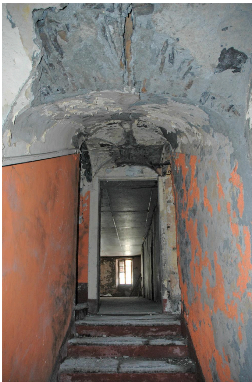
Vue intérieure de l'escalier : volée aboutissant au 2e étage.
