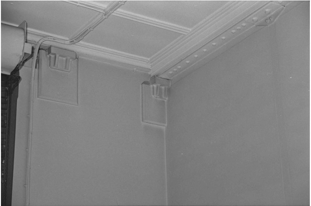
Supports en fonte implantés dans le mur pour poutres en acier. Pavillon FG, mur est, angle nord-ouest.
