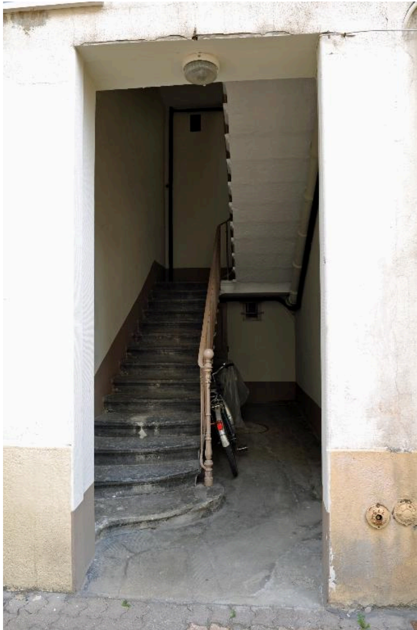
Immeuble sur cour, vue de l'entrée dépourvue de fermeture
