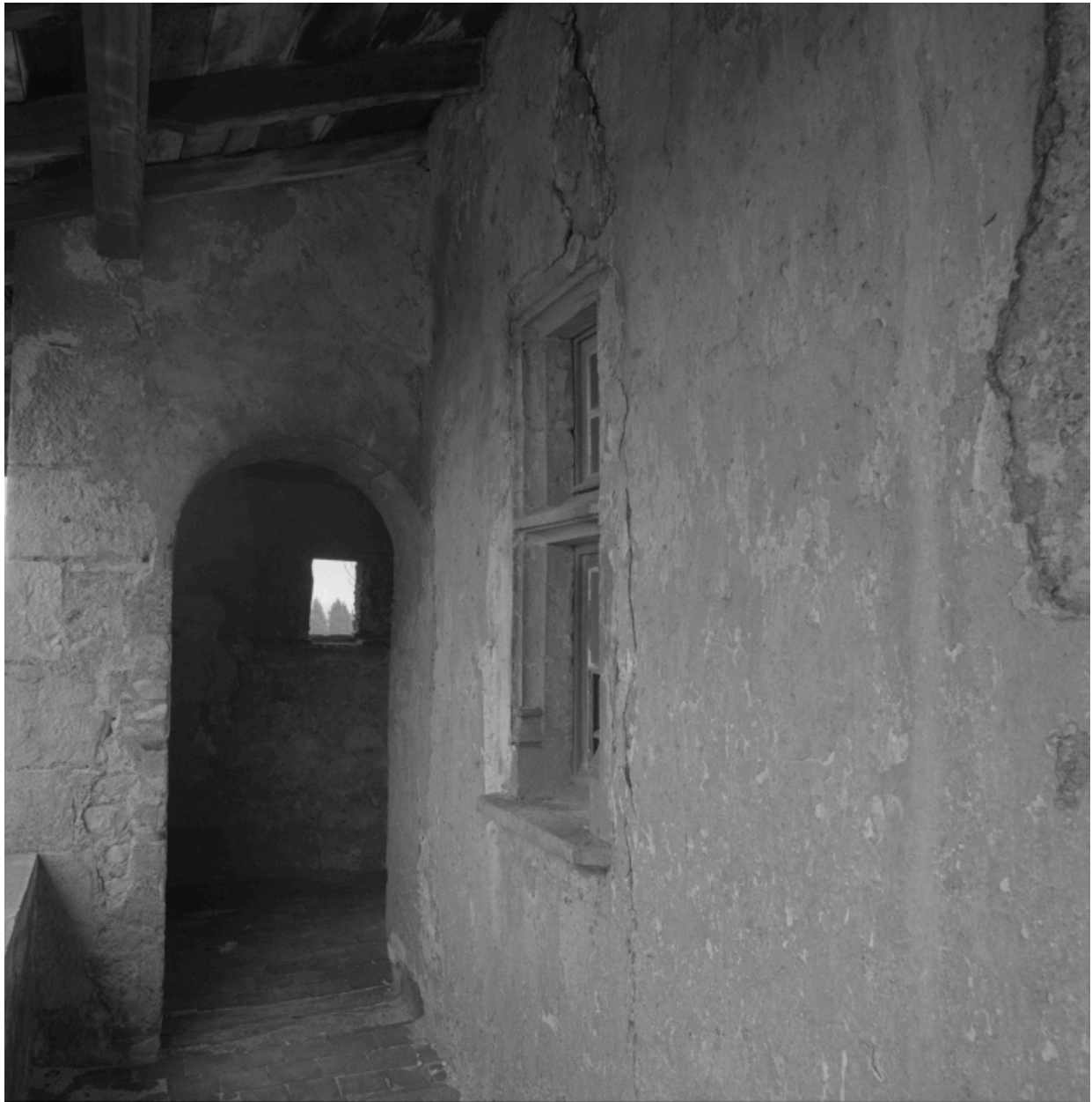
Etage en surcroît côté nord, galerie haute : fenêtre à traverse moulurée.
