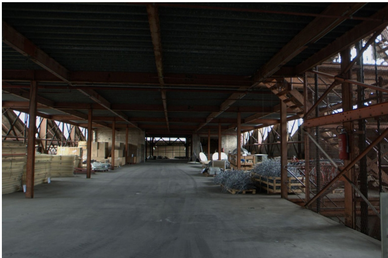
Premier étage halle centrale
