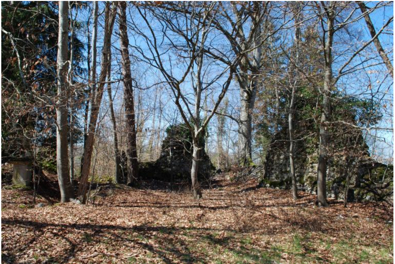
Château, élévation intérieure de l'angle nord-est des murs.
