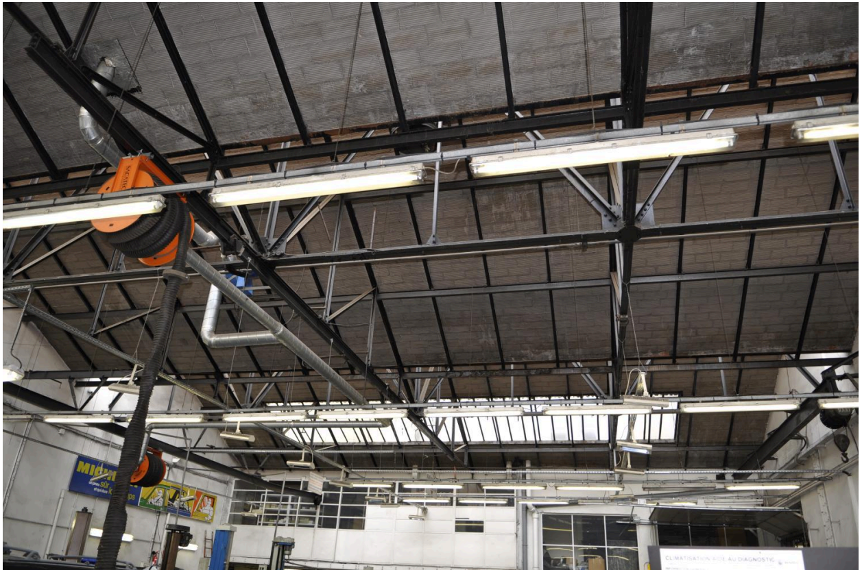
Vue intérieure du garage, toiture en brique et tuiles rouges
