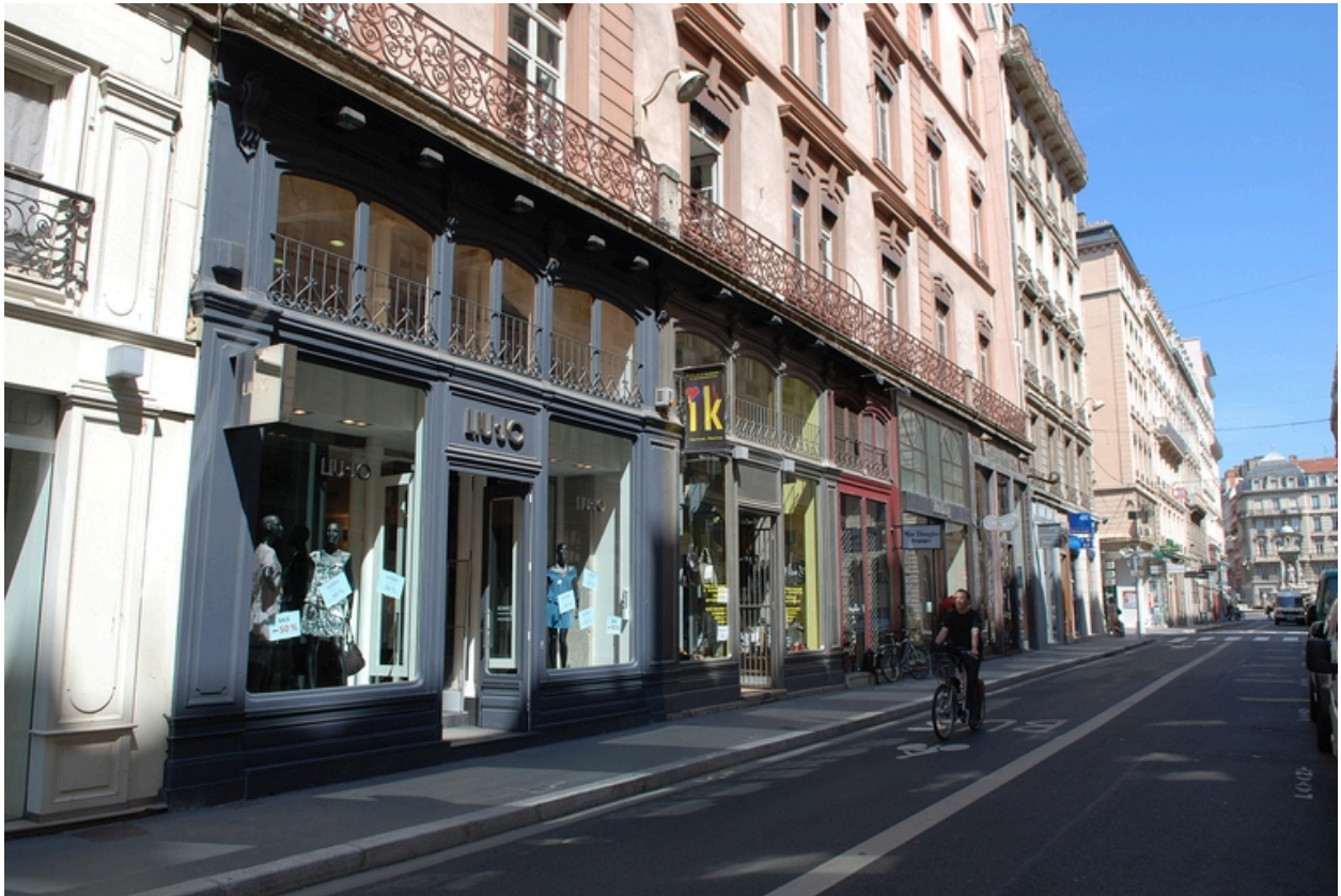
Elévation rue Gasparin : le rez-de-chaussée vers la place des Jacobins
