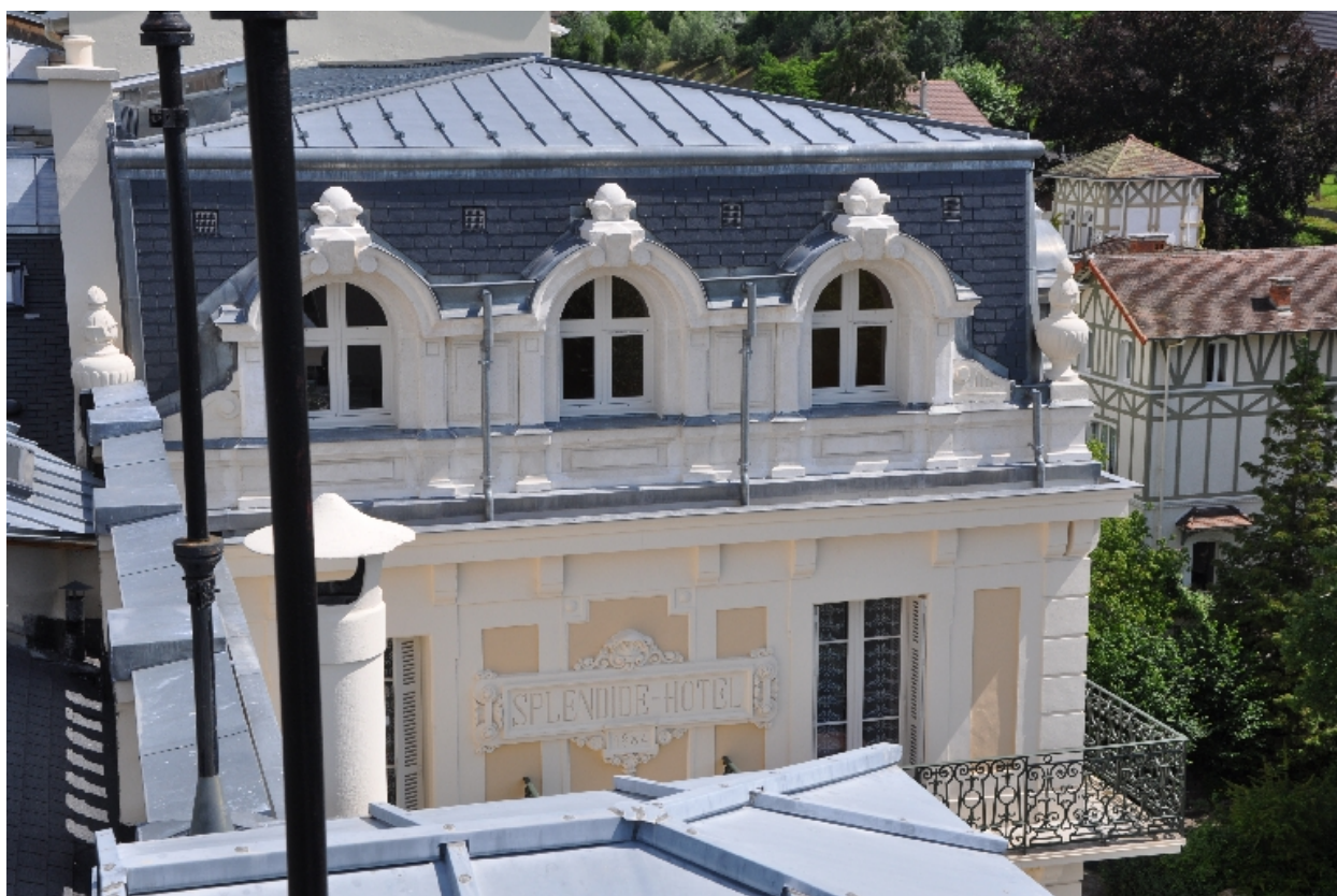
Toiture de l'extension nord-est
