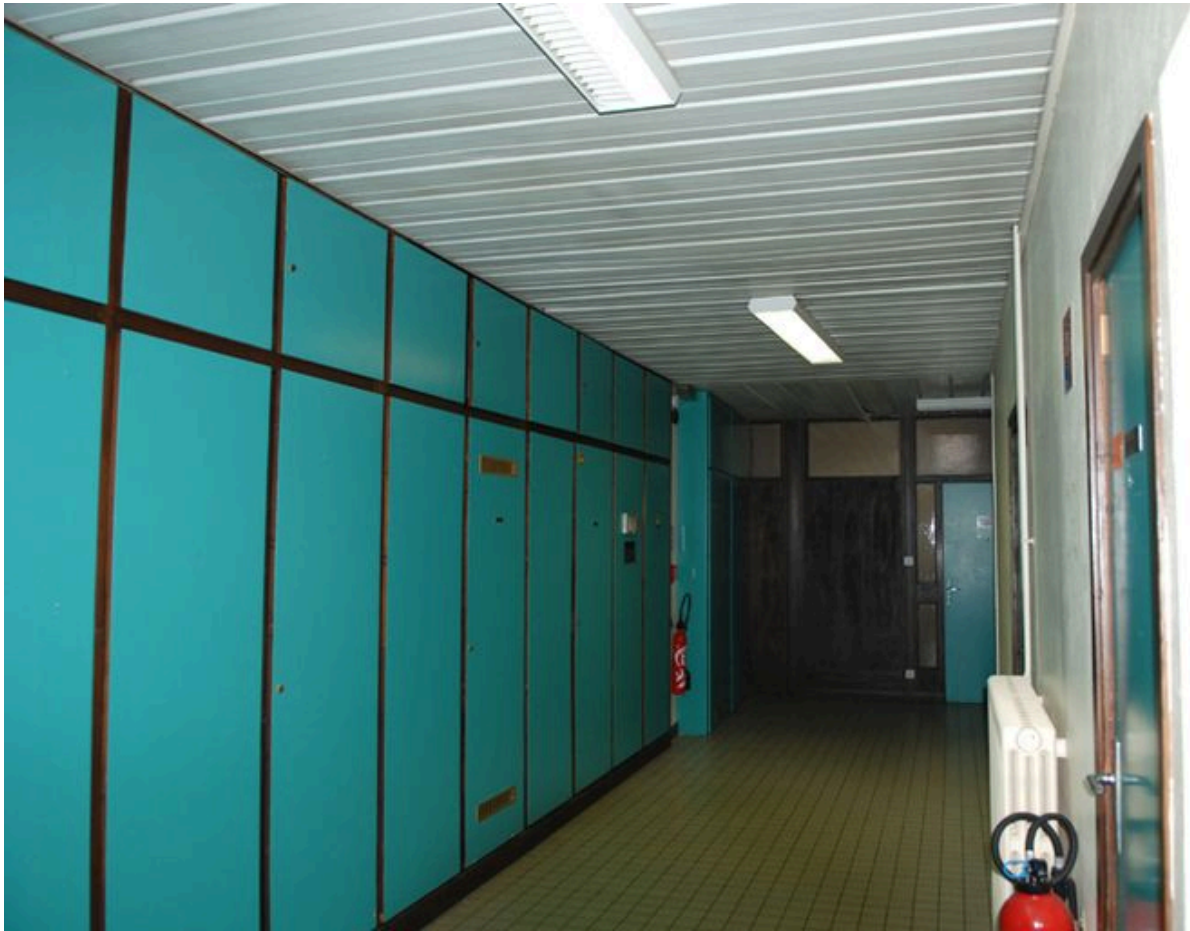
Bâtiment ISARA (2e tranche), couloir en sous-sol.
