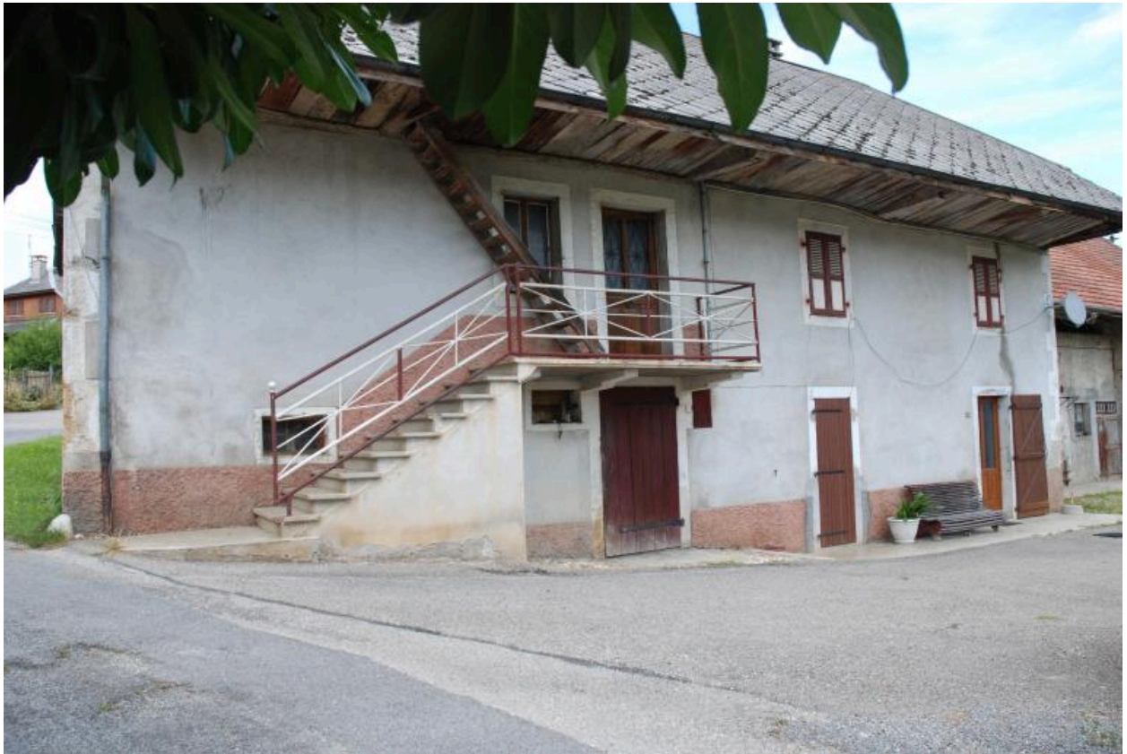
Vue d'ensemble de l'habitation ouest.
