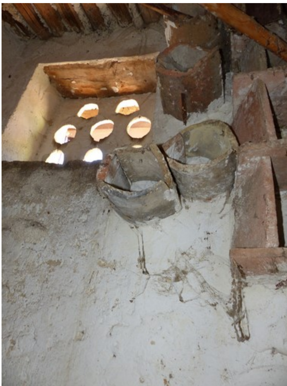
Colombier. Mur sud, boulins.
