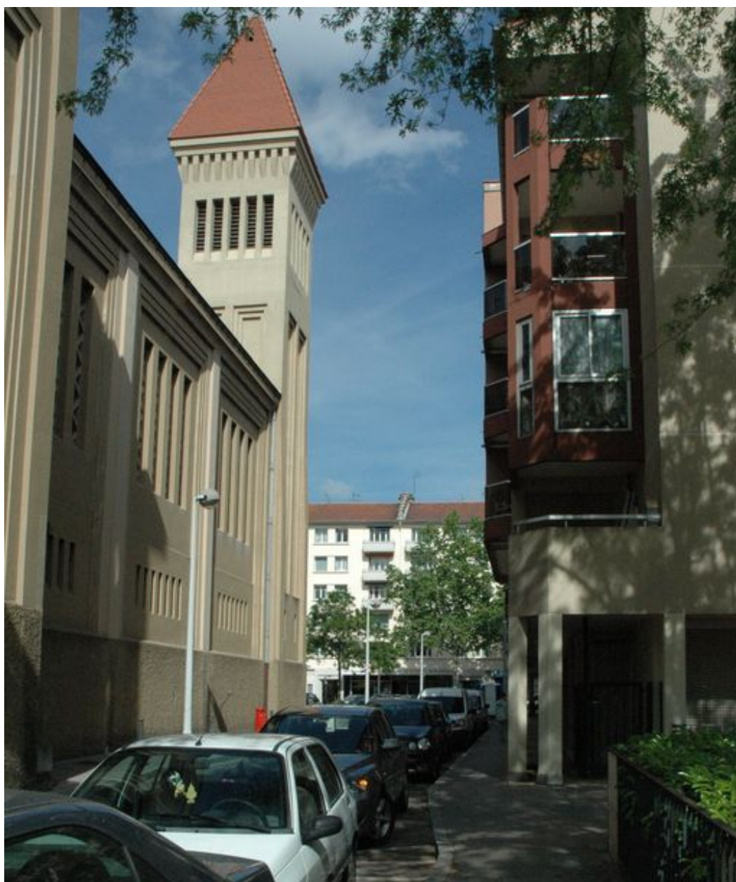
Façade sud : la nef et le clocher vus depuis l'ouest
