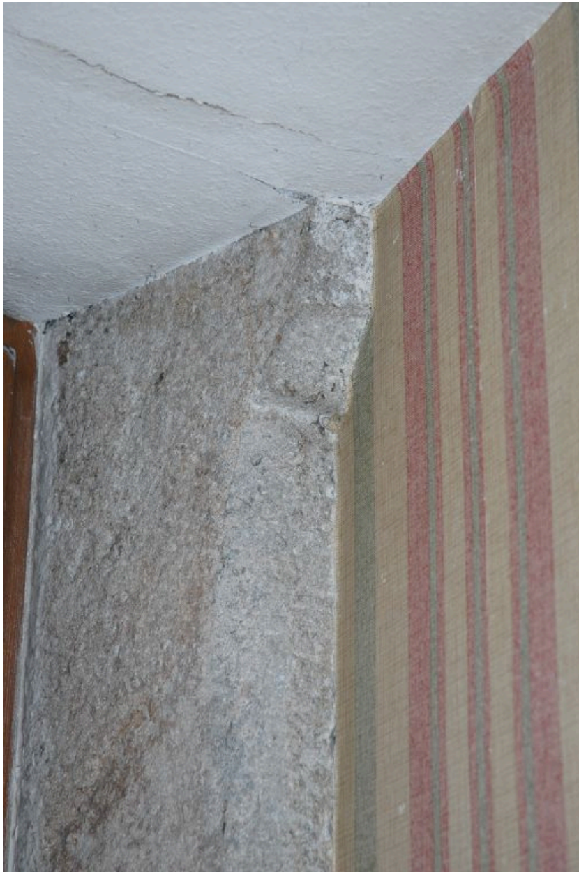
Pilier monolithe portant la sablière.
