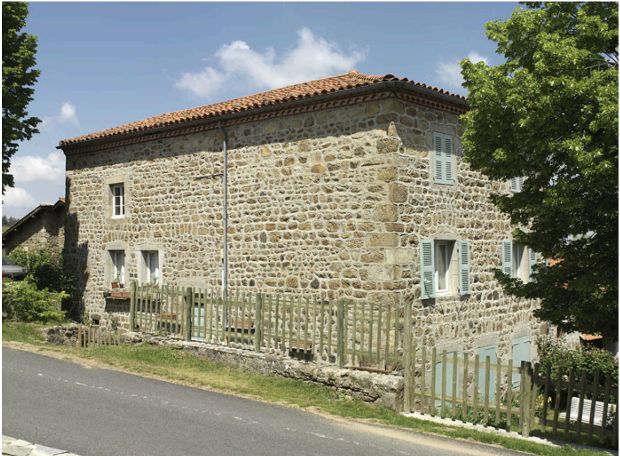
Vue de trois-quarts sud-ouest.
