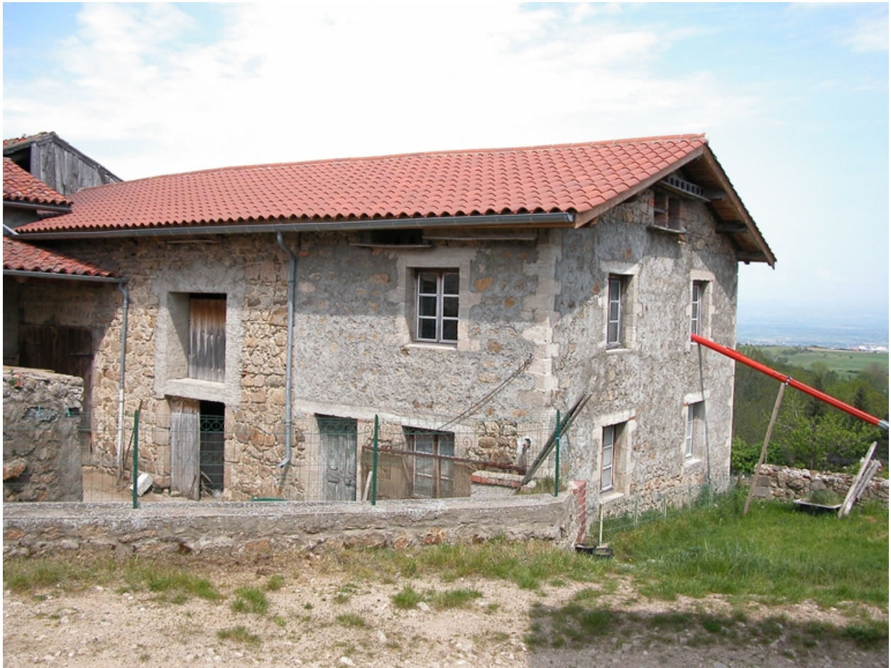
Vue d'ensemble de la grange-étable.
