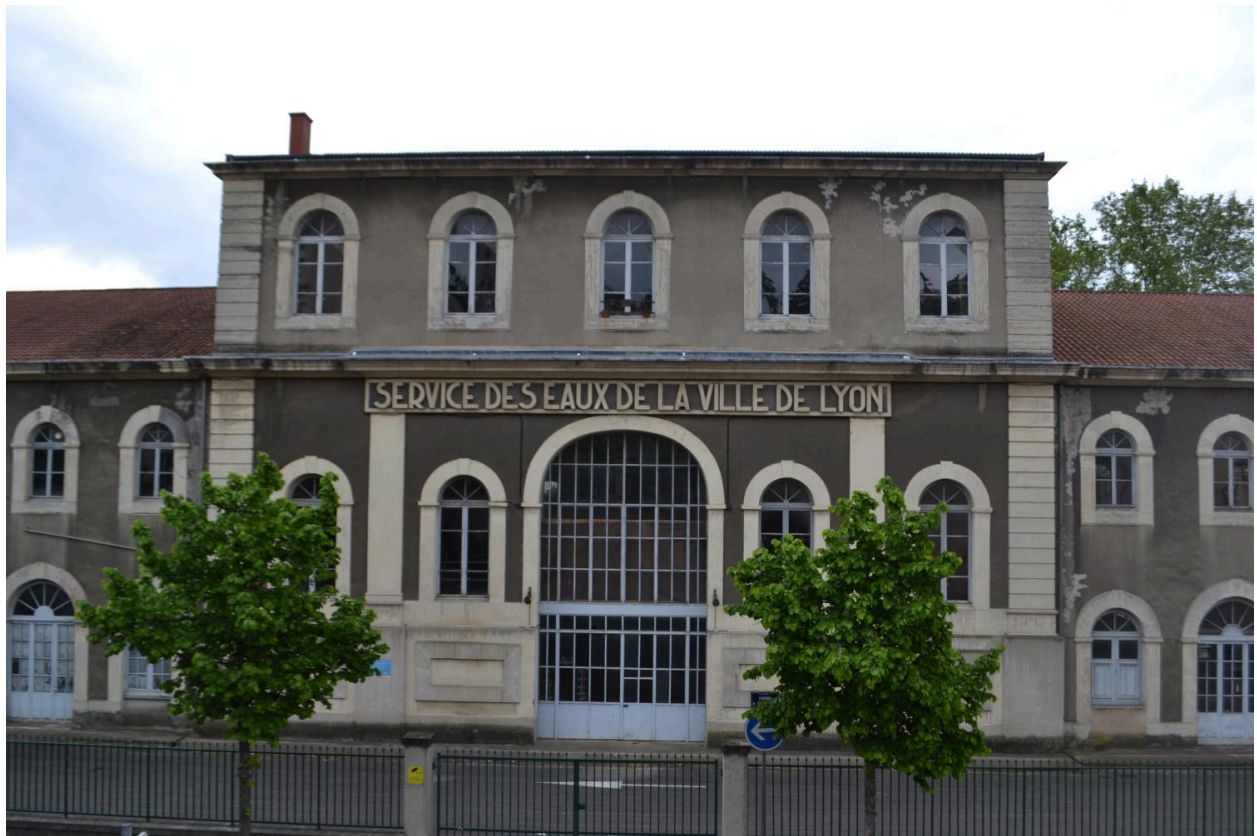
Façade principale sur rue
