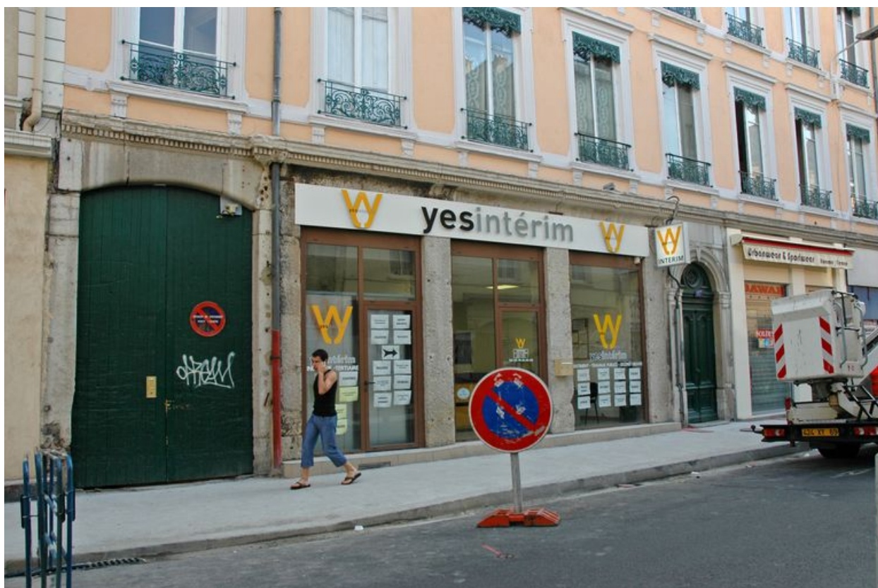
Vue d'ensemble des boutiques au rez-de-chaussée
