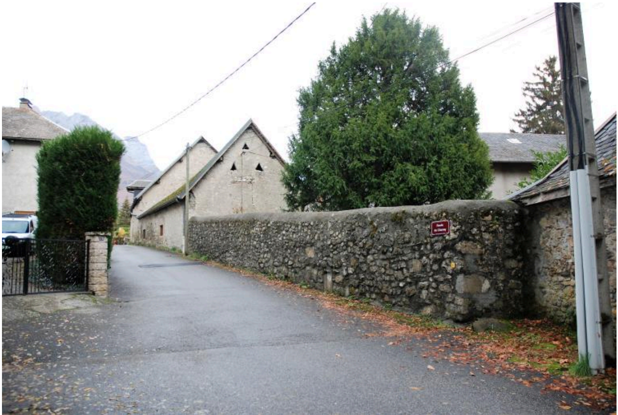
Vue d'ensemble du mur de clôture nord, dans le prolongement de la chapelle.
