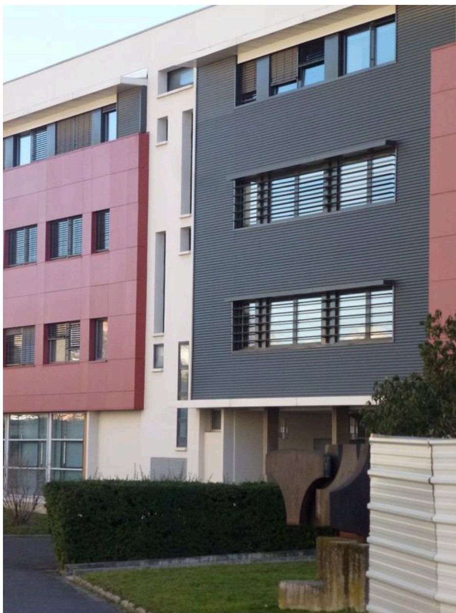
Détail du bâtiment B (classes et CDI) montrant la surépaisseur du refaçadage par rapport à la travée d'origine (travée d'éclairément d'un l'escalier). (Photo chercheure.)
