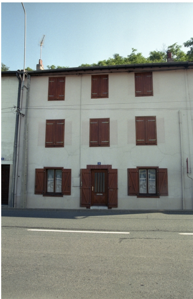
Boën, îlot 20, RN 89, 19. Vue générale de la façade sur rue.
