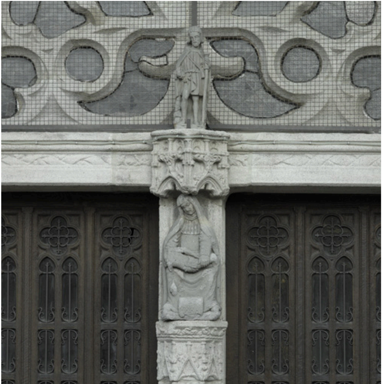
Détail du pilier central.
