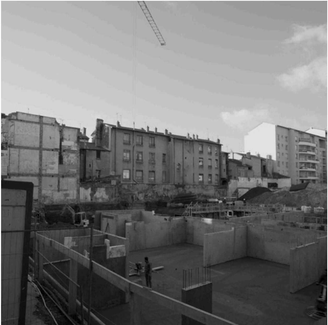
Vue sud-est (arrière) du bâtiment
