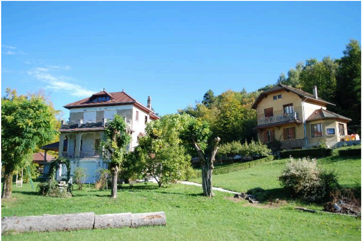
Vue d'ensemble du site de la Châtaigneraie.
