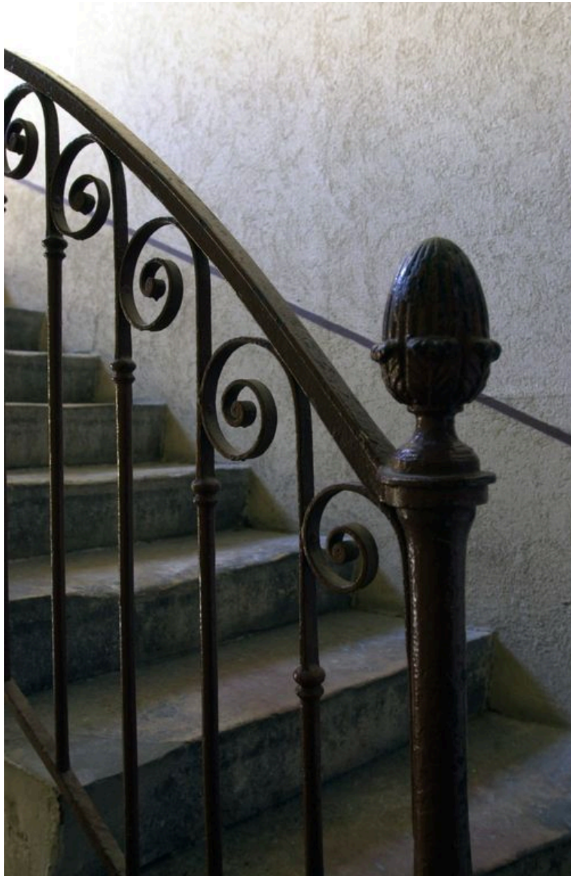
Détail du départ de la rampe
