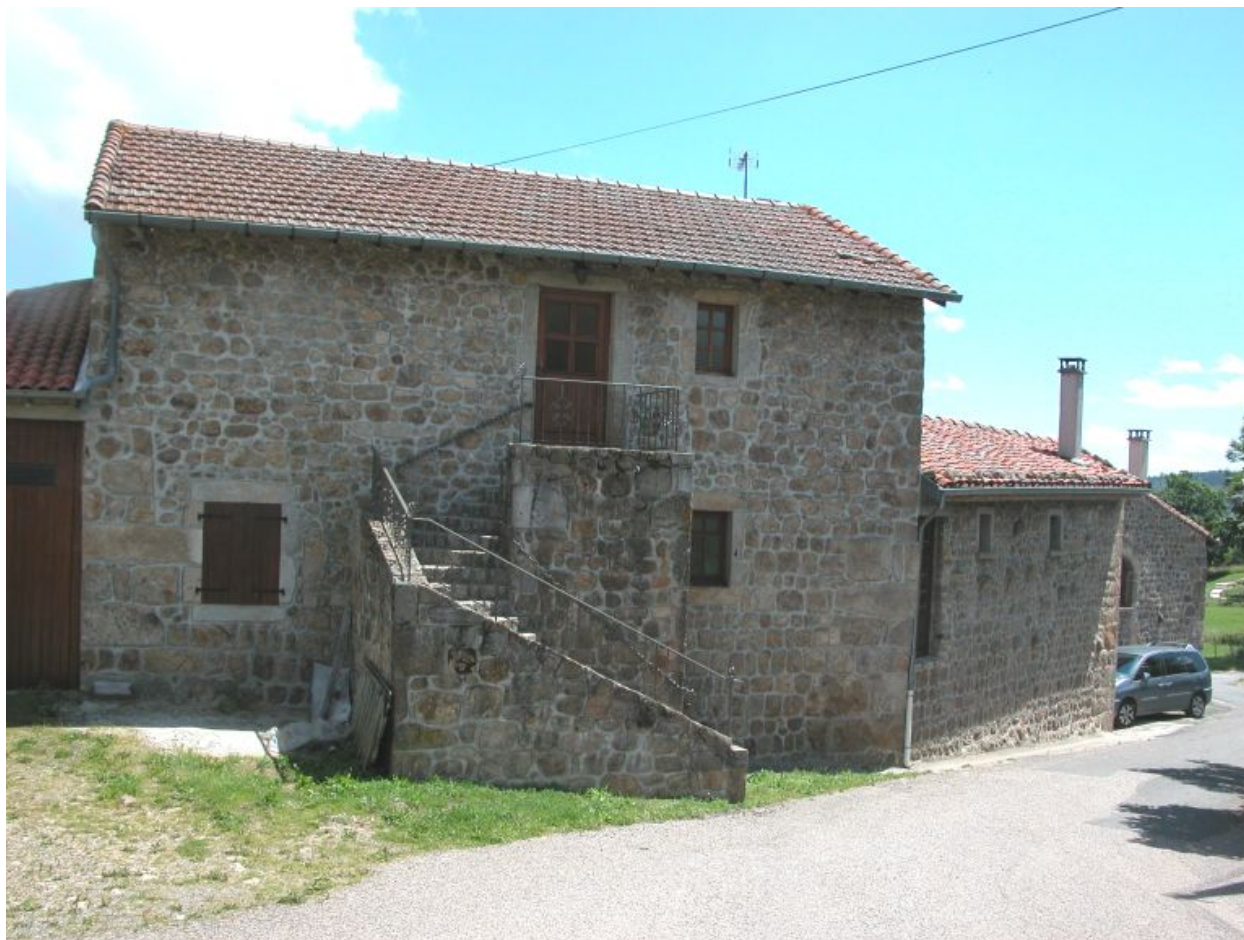
Vue arrière du logis sur cour (1986 AD 357)
