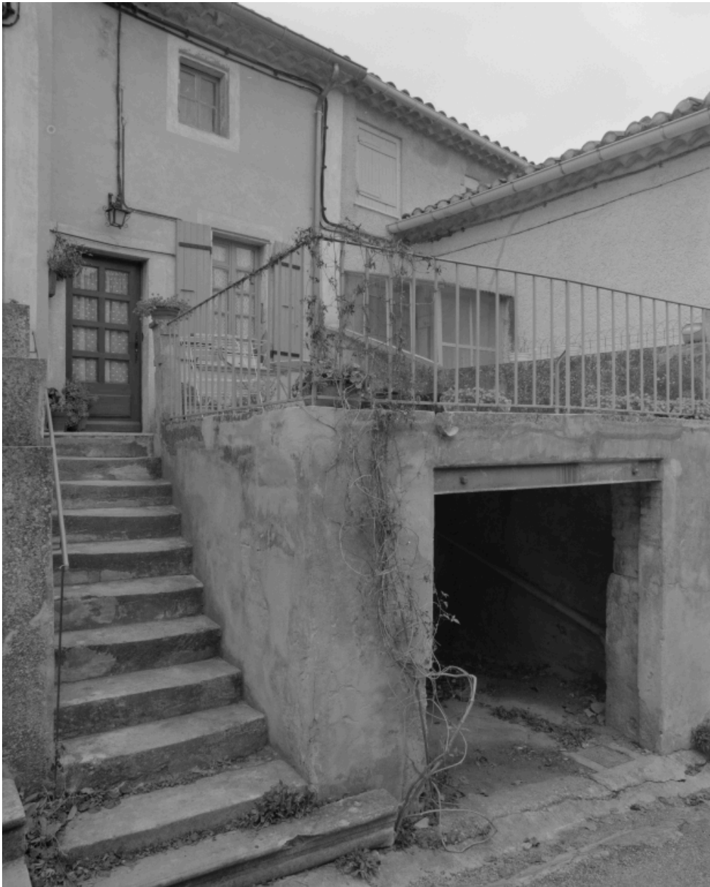
Le Village. Vue d'ensemble de la ferme (A1 179).
