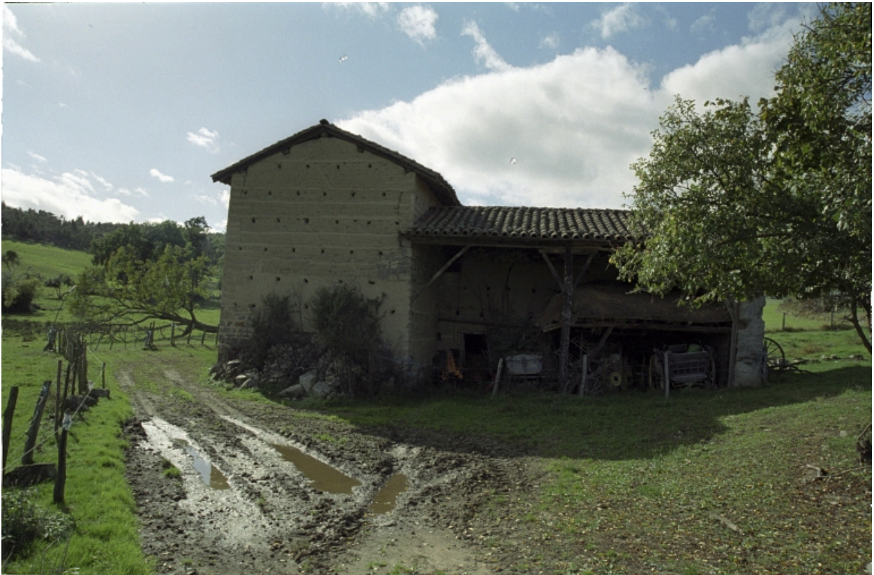
Vue d'ensemble des dépendances situées sur l'arrière du logis, depuis l'ouest.
