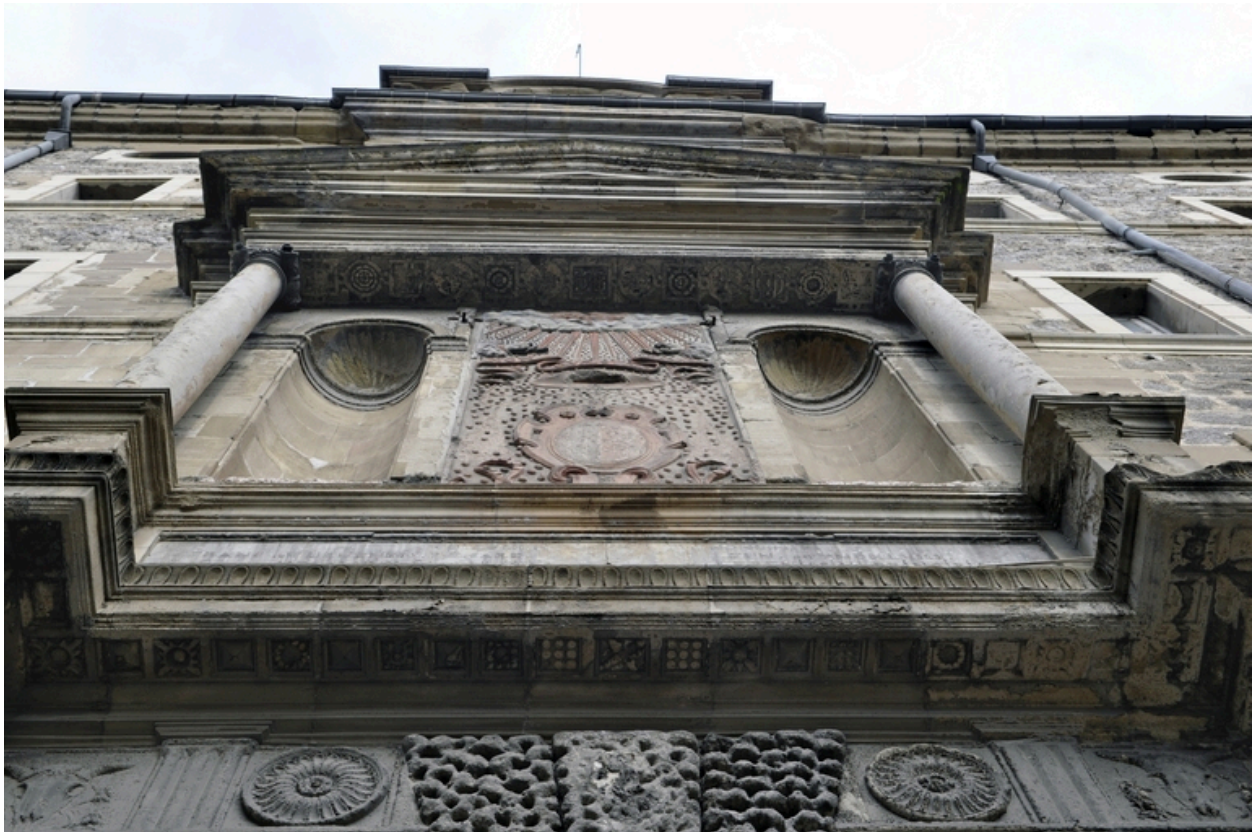
Registre supérieur, vue d'ensemble depuis le bas ; timbre à date au centre, sur le soffite
