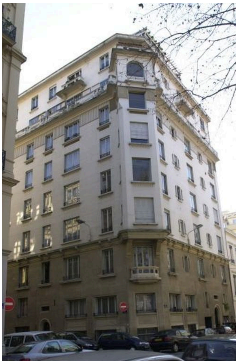
Vue générale de l'élévation
