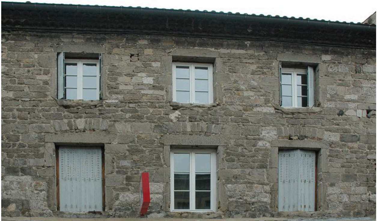
Élévation sur rue, vue partielle.
