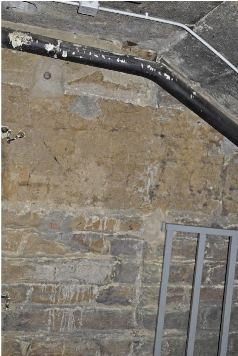
Bâtiment central, vue intérieure montrant l'association des matériaux au niveau du soubassement
