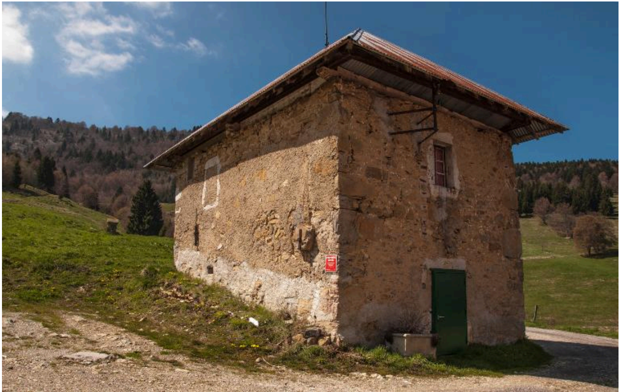
Ancienne habitation sur cave, façades sud et est.
