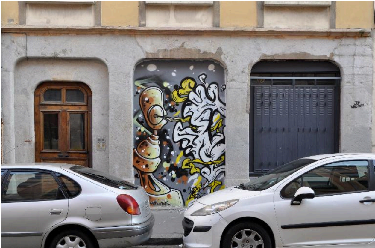
Elévation sur la rue Thibaudière, arcades en méplat du rez-de-chaussée, porte piétonne
