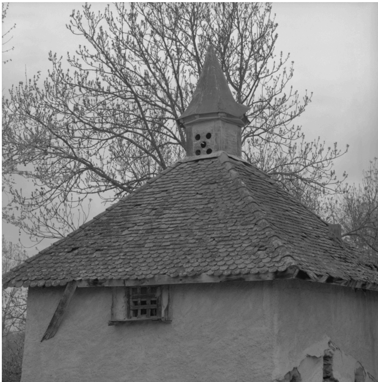
Vue de la toiture, du nord-est.
