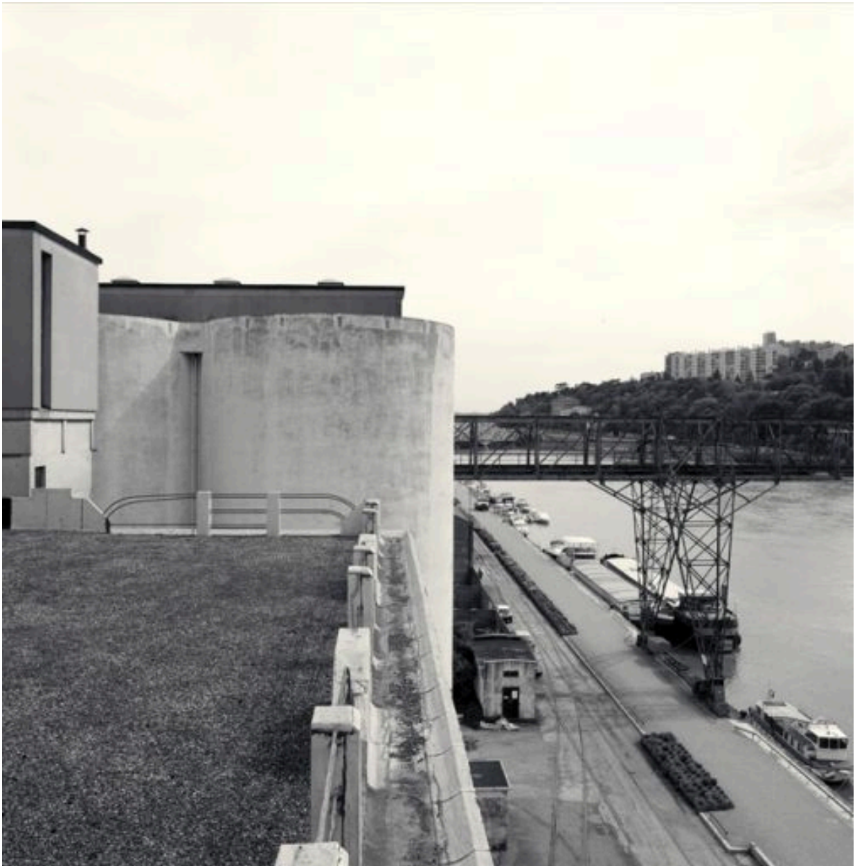
Les silos depuis le toit terrasse au nord
