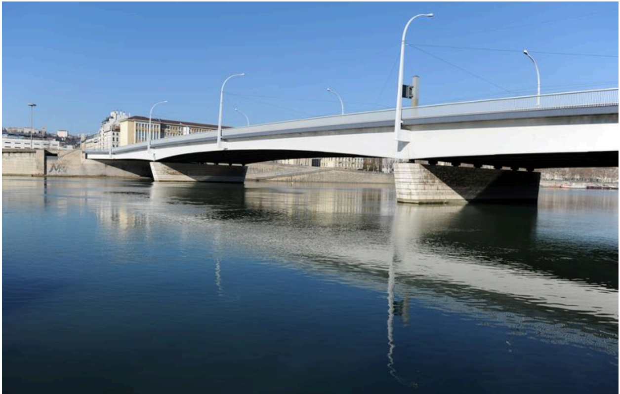
Vue partielle, travées droite et centrale, face aval (depuis la rive gauche)
