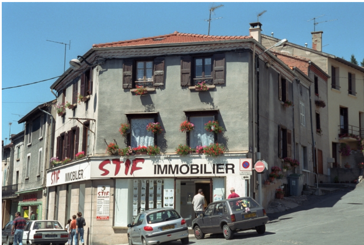
Boën, îlot 12, Clermont (rue de) 37. Vue générale de la façade sur rue.
